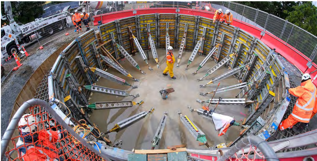
Concrete pour, Lyon Ave site
